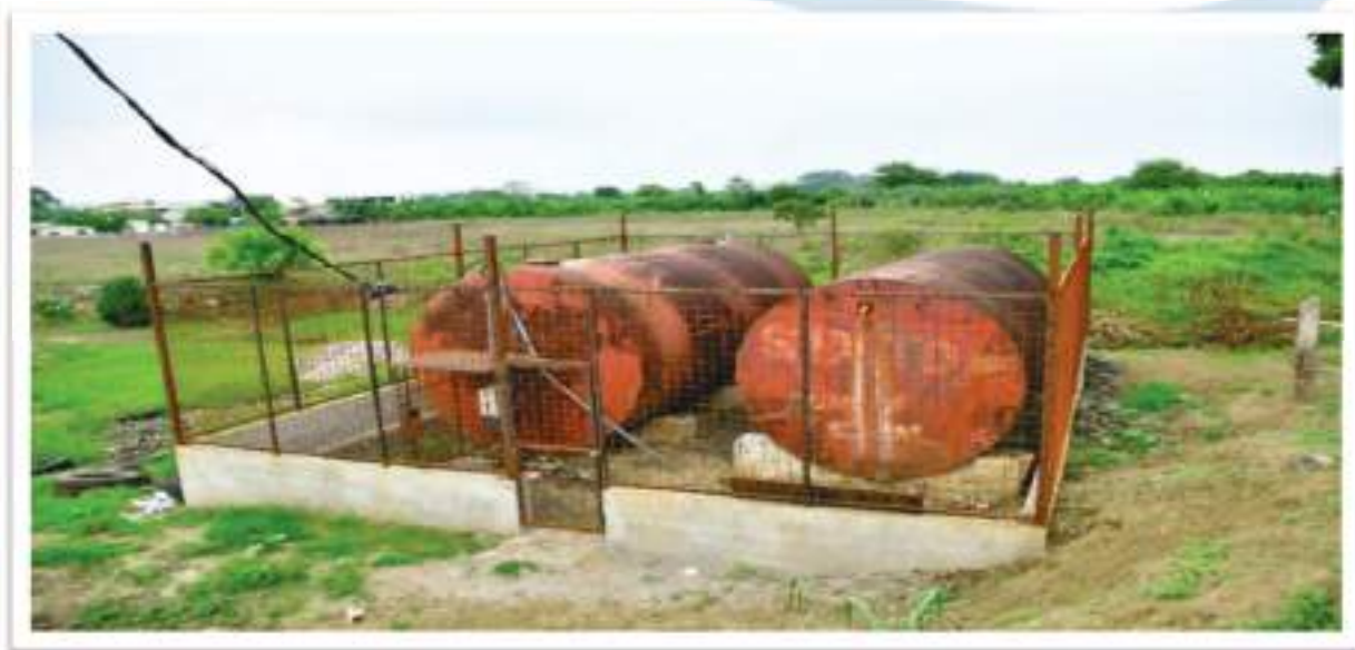
Imagen 11.- Tanques de agua. Fotografía: Empresa Pública Estudios y Construcciones ULEAM-EP
