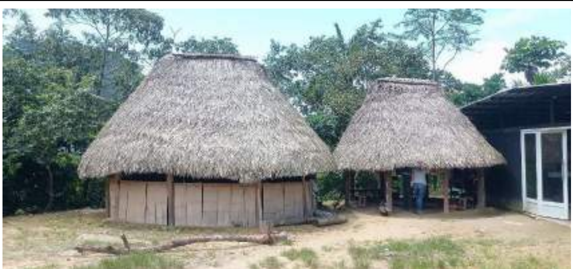
Tipología arquitectónica 1: En la imagen observamos dos chozas de forma cónica, con base circular, ubicadas en un campo abierto. Sus paredes, construidas con caña
