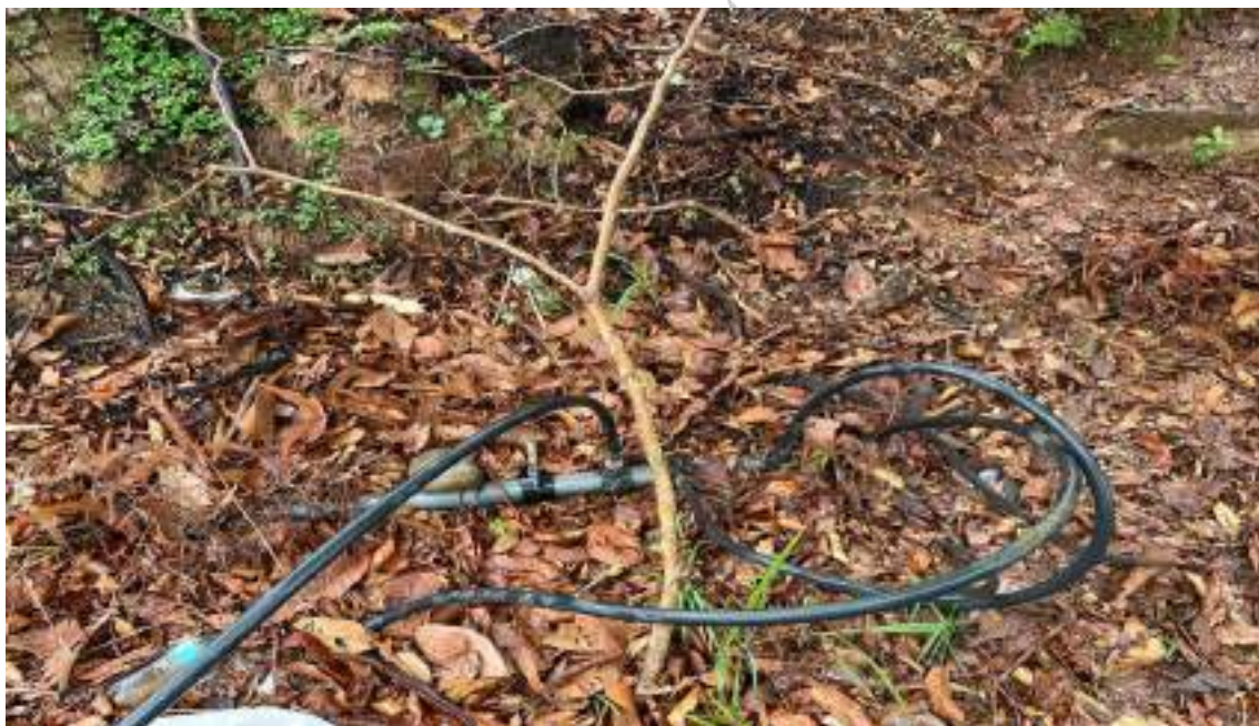
Fotografía 14. Conexiones domiciliarias en tubería de impulsión
